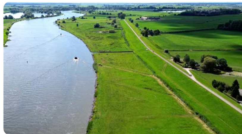
Figuur 10: Dijk Mastenbroek-IJssel (ter hoogte van 's Heerenbroek)
