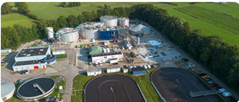
Figuur 7: Groengasinstallatie rwzi Echten
