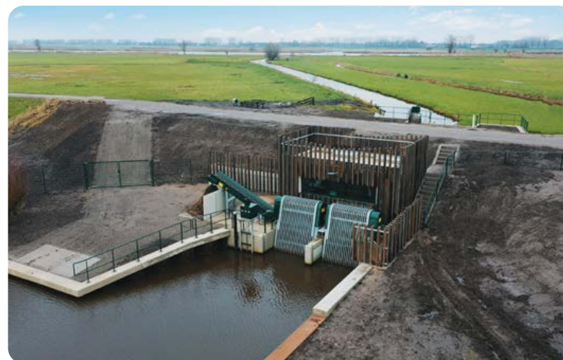
Figuur 12: Gemaal Cellemuiden (duurzaam gemaal)
